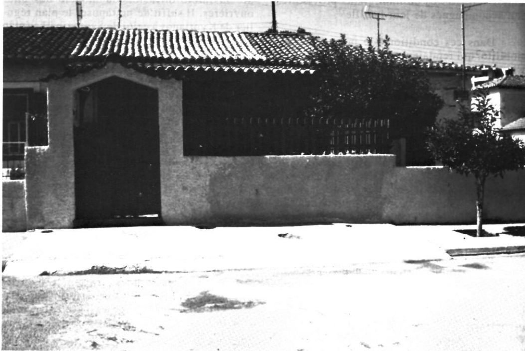
10. Kyprianos. Intervention récente sur la clôture de la cour.
